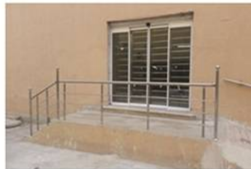
ساخت و نصب درب های الکترونیک با حفاظ (ورودی و خروجی)
