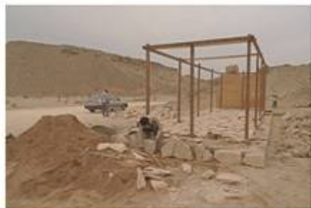
سایبان های چوبی در حال اجرا
