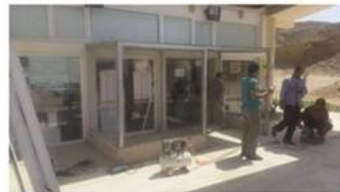
ایجاد باکس شیشه ای ورودی مسقف در ساختمان پذیرمان دره ستاره ها
