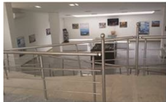
نصب نرده های رمپ داخلی ساختمان پذیرمان دره ستاره ها
