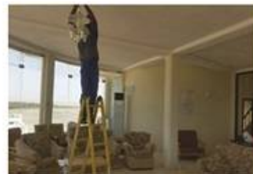
ساماندهی سیستم برقی و نصب دو کولر ایستاده ساختمان سهیلی
