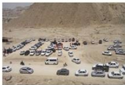
ساخت پارکینگ خاکی در نزدیکی ورودی سایت
