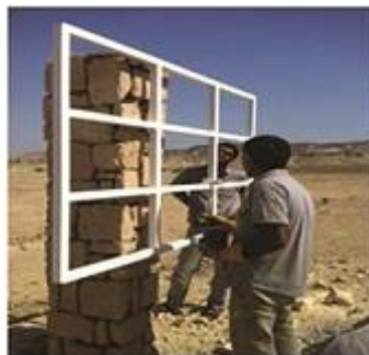
ساخت تابلو اطلاع رسانی دره تندیس ها
