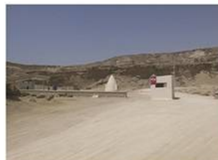
خاکریزی و جاده سازی از روستا برکه خلف تا ورودی سایت
